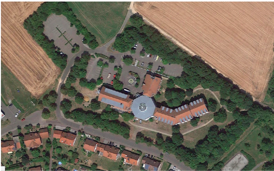
Foto_01 Luftaufnahme Bestand (Google Maps)
